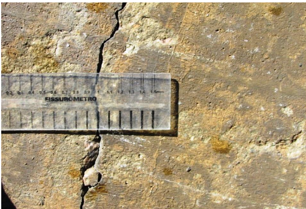
Foto 43: Vista do bloco de fundação do apoio 08 – Aproximação da foto anterior
