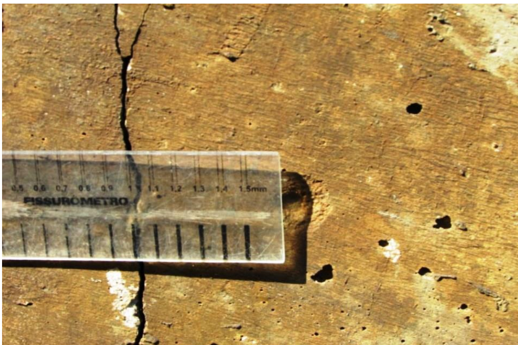
Foto 37: Vista do bloco de fundação do apoio 07 – Aproximação da foto anterior
