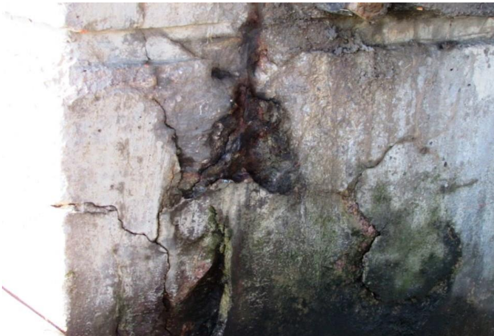
Foto 41: Vista do bloco de fundação do apoio 08 – Aproximação da foto anterior
