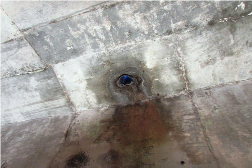
Foto 73: Vão 06 – dreno em tubo de PVC curto, com diâmetro de 4”, posicionado entre as vigas longarinas VL.03 e VL.04.
