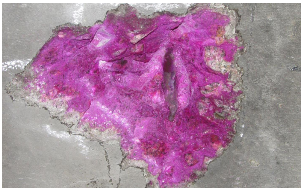
Foto 7: Vista do bloco de fundação do apoio 01 – ensaio de carbonatação na travessa – face norte
