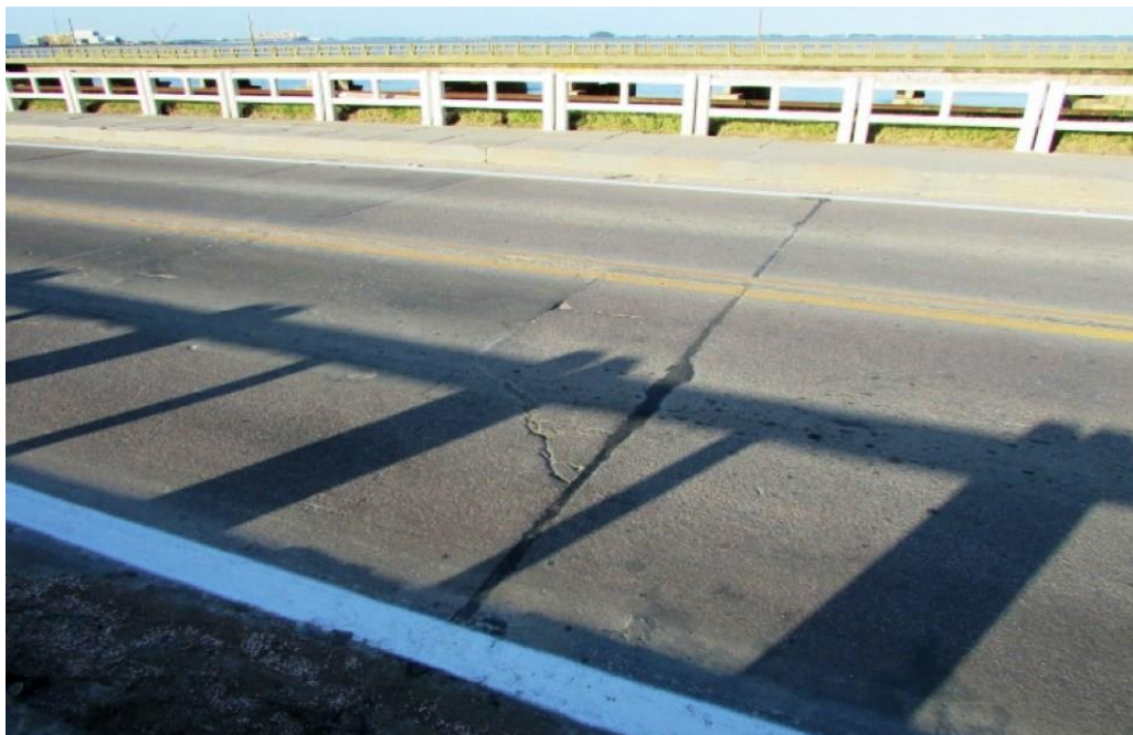
Foto 143: junta de dilatação locada sobre a projeção da linha de apoio 07
