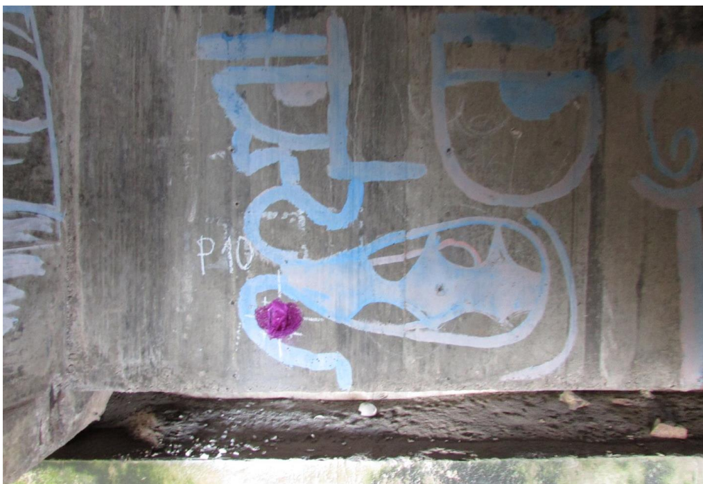
Foto 48: Vista do bloco de fundação do apoio 09 – ensaio de carbonatação na travessa – encontro norte / face sul
