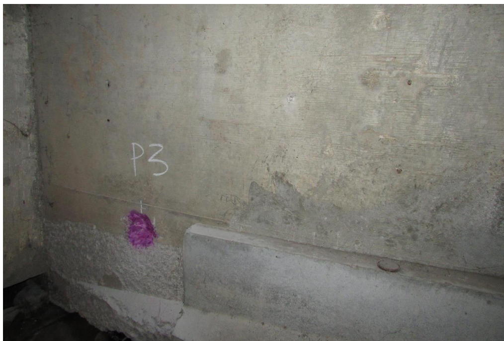
Foto 94: Face lateral longarina VL03 – ensaio de carbonatação (solução de fenolftaleína). Viga Longarina VL.3 – Encontro Sul – Face Leste
