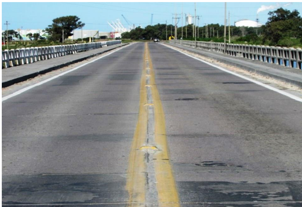
Foto 126: Vista Geral do pavimento rígido da via sobre a obra.
