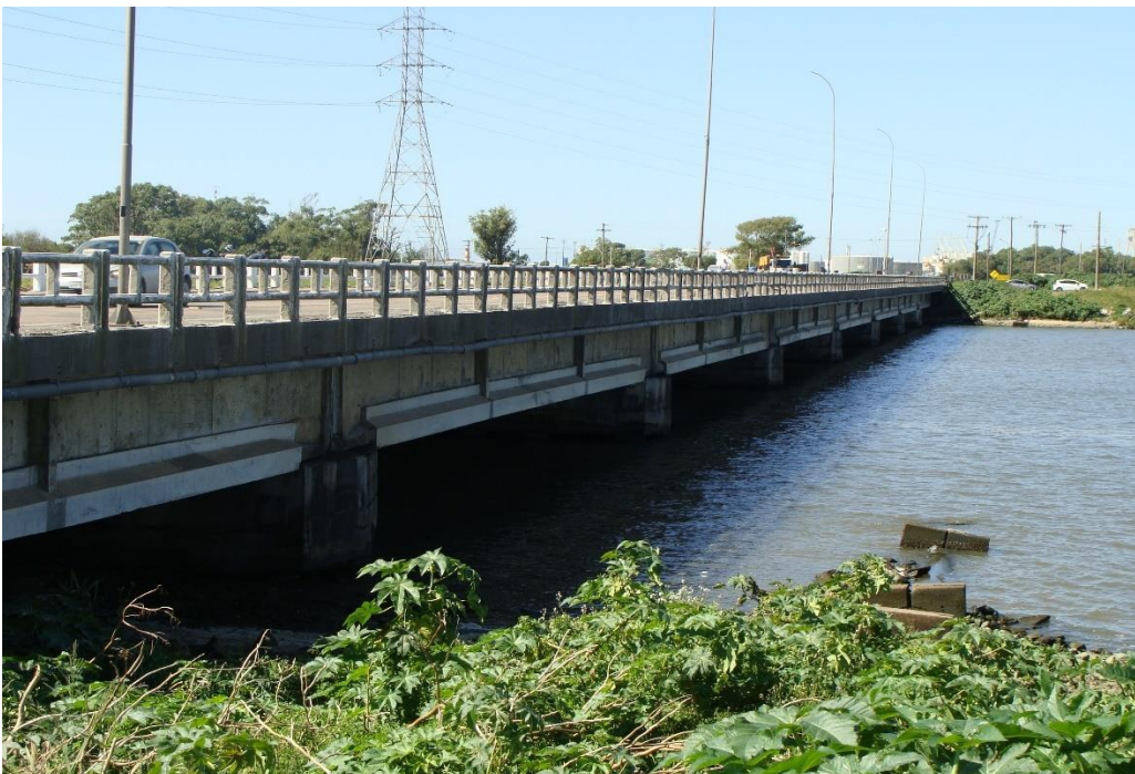
Foto 114: Face lateral longarina VL04 – Vista geral da lateral da viga VL04
