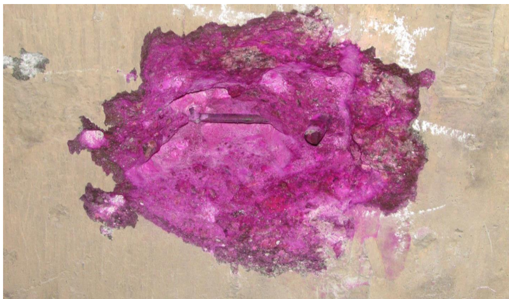
Foto 6: Vista do bloco de fundação do apoio 01 – ensaio de carbonatação na travessa – face norte
