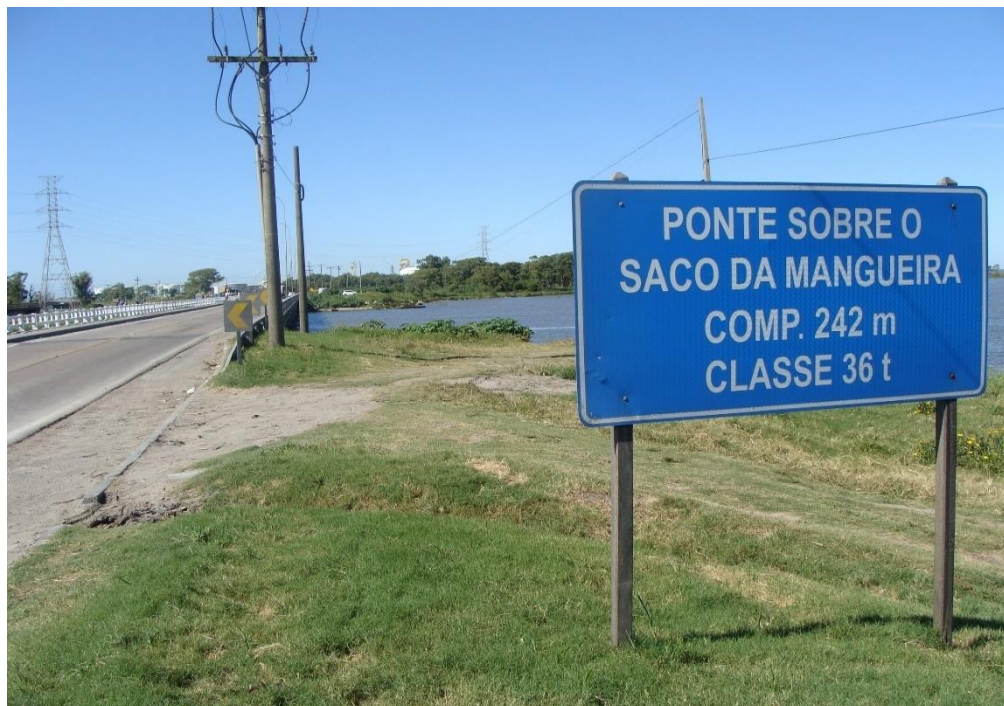
Foto 1: Placa de sinalização Ponte sobre o Saco da Mangueira
