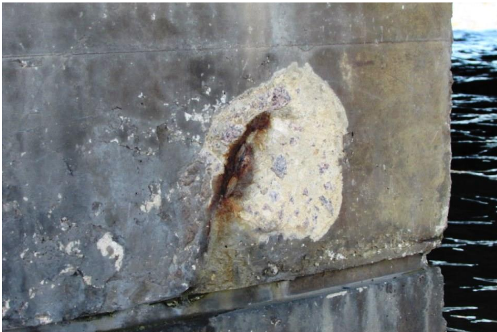
Foto 27: Vista do bloco de fundação do apoio 05 – Aproximação da foto anterior.
