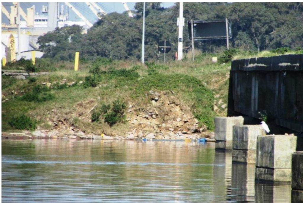
Foto 124: Vista do ao maciço de solo lateral ao lado Oeste da OAE, no encontro Nortel da OAE.
