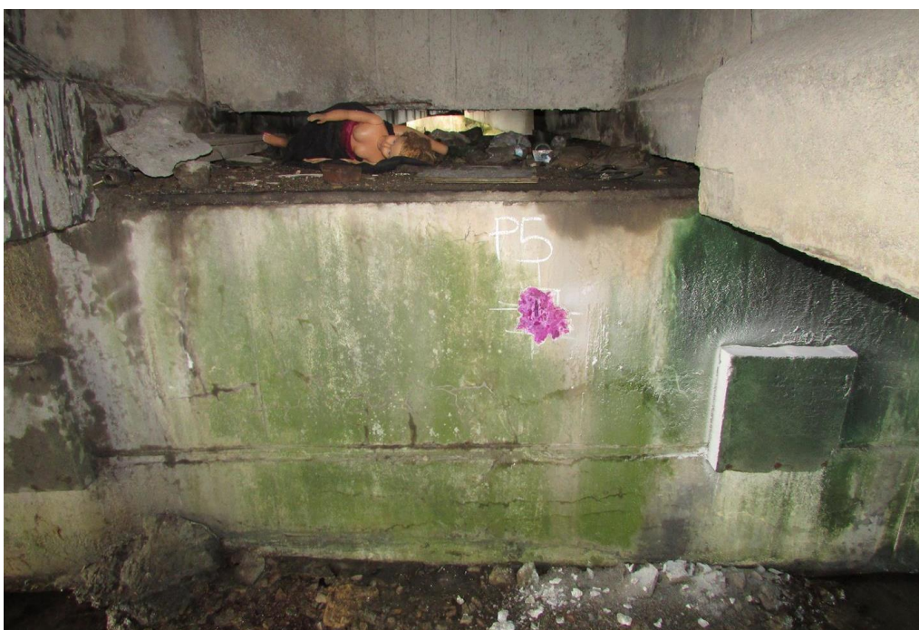
Foto 19: Vista do bloco de fundação do apoio 02 – ensaio de carbonatação na travessa – face sul
