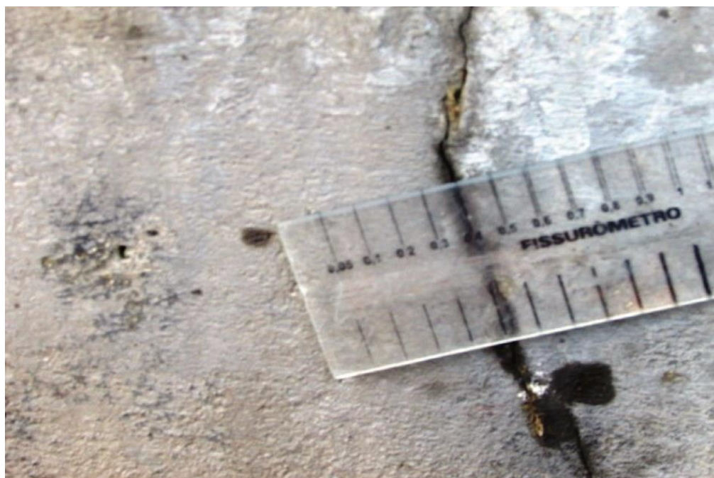
Foto 33: Vista do bloco de fundação do apoio 06 – Aproximação da foto anterior.
