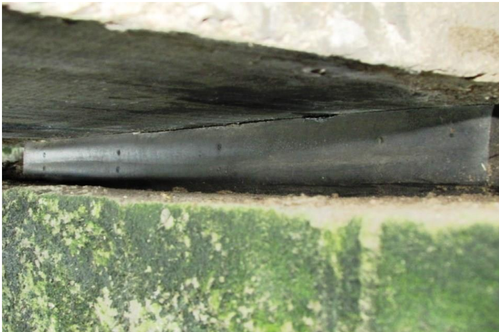
Foto 45: Vista do bloco de fundação do apoio 09 – Aproximação da foto anterior.
