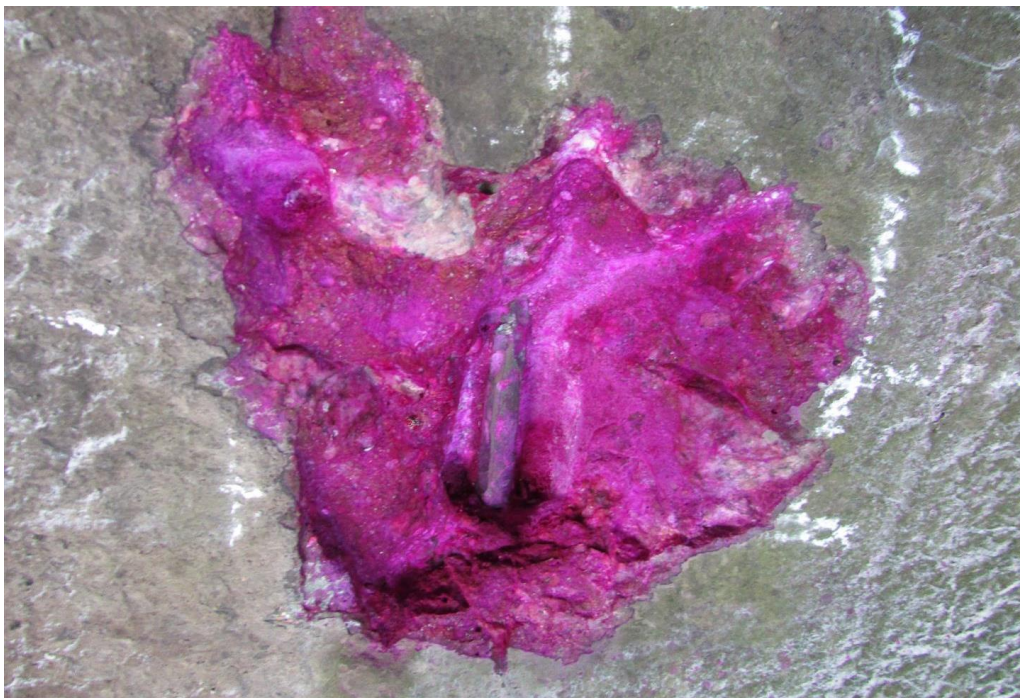
Foto 47: Vista do bloco de fundação do apoio 09 – ensaio de carbonatação na travessa – encontro norte
