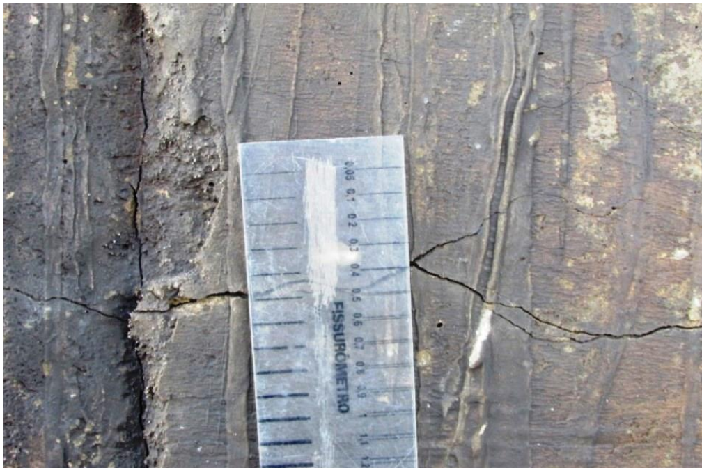
Foto 29: Vista do bloco de fundação do apoio 05 – Aproximação da foto anterior
